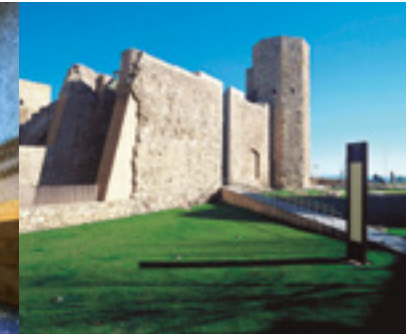
Ondergrondse tunnels van het circus en pretorium
