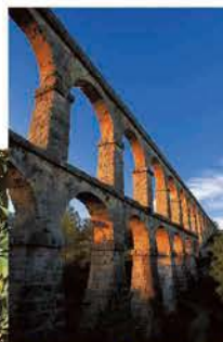
◀ Acueducto romano de les Ferreres. © Aqueduc romain de les Ferreres.
